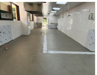
⑧ 시공 완료
